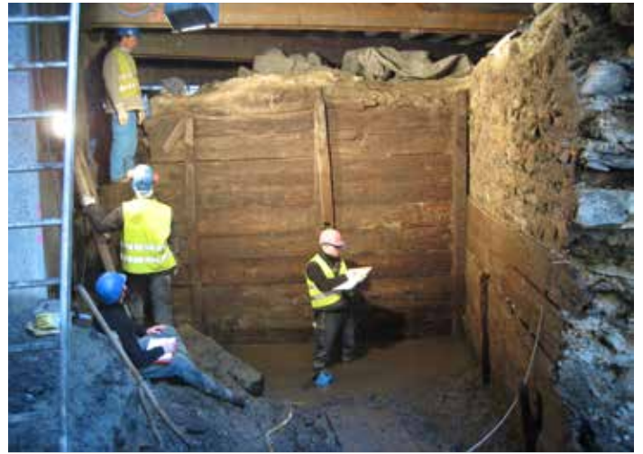
Abb. 6 Köln, Kurt-Hackenberg-Platz, Römische Tannenzuschalung der Fundamente des Abwasserkanals und der Stadtmauer, Blick von Norden. Foto: Alfred Schäfer
