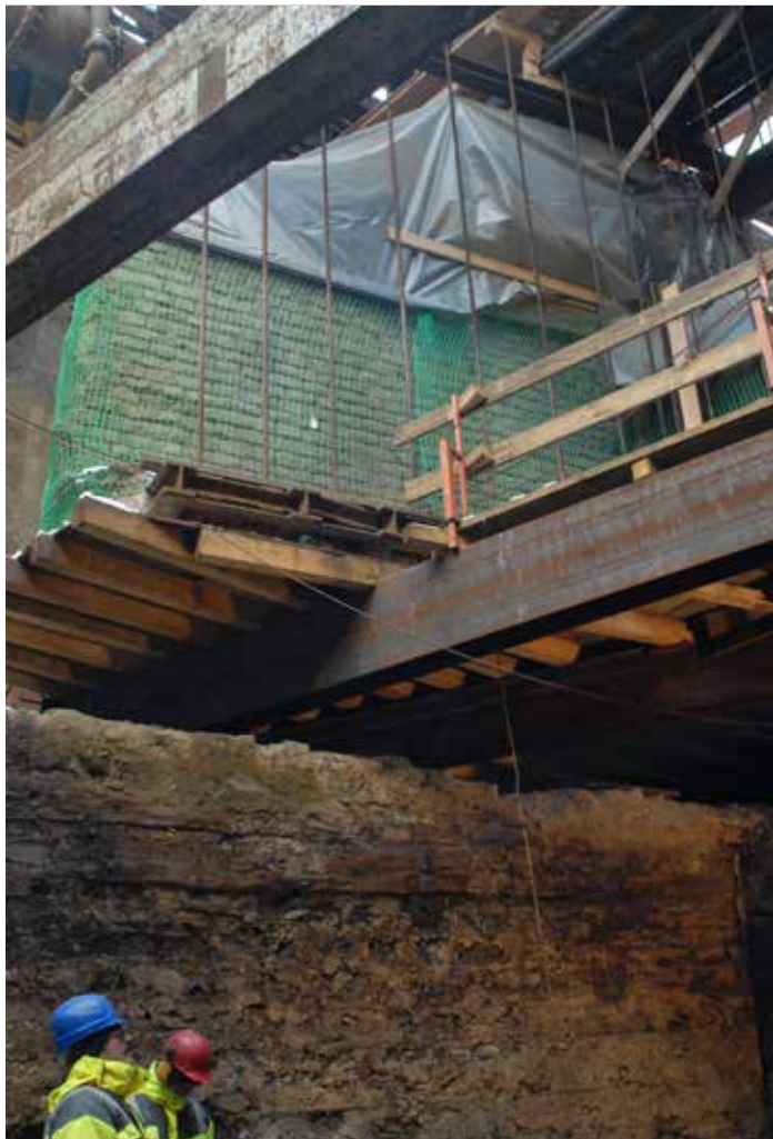
Abb. 9 Köln, Kurt-Hackenberg-Platz, Aufhängung des römischen Hafentores in der offenen Baugrube. Foto: Alfred Schäfer
