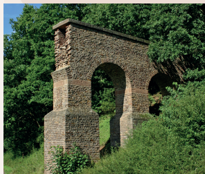
Mechernich-Vusse: Über Originalbefunden rekonstruierte Aquäduktbrücke
