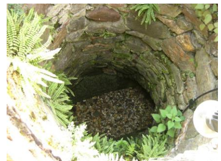
Einstiegsschacht der römischen Eifelwasserleitung in Buschhoven.
