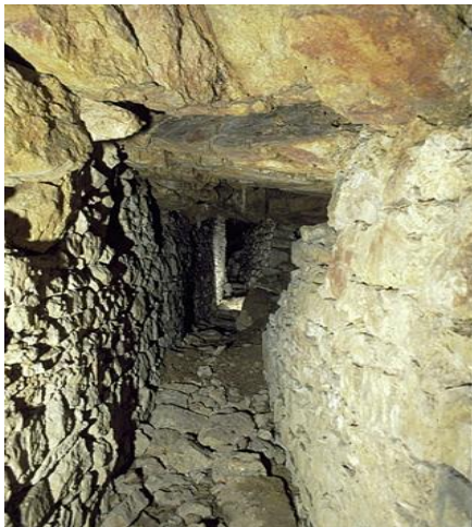
Blick in den Blankenheimer Tiergartentunnel kurz nach der Wiederfreilegung 1997
